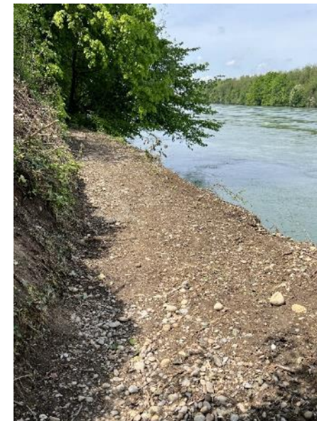
Der mit einem Beitrag von WbB sanierte anspruchsvolle Rheinuferweg in Augst
